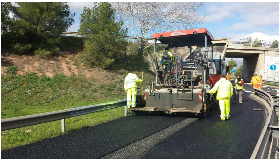
Operació d'asfaltatge en una carretera.
